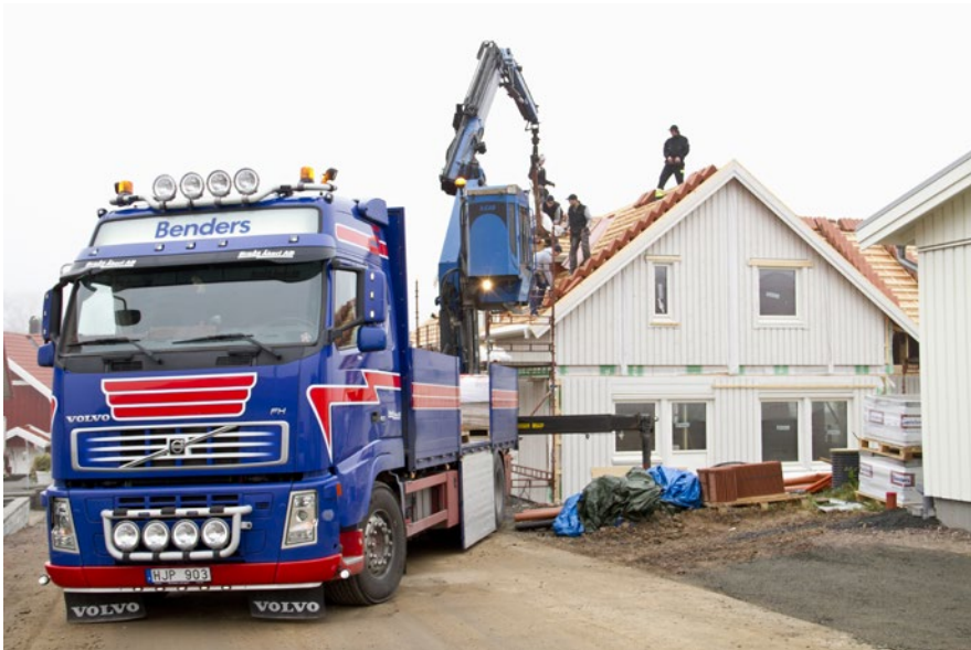
Pilt 1. Kraanaga autolt katusele tõste.
