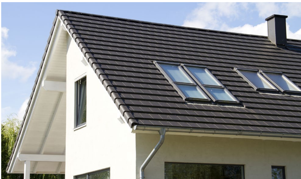
Pilt 24. Carisma katusekivid universaalse äärekiviga.
