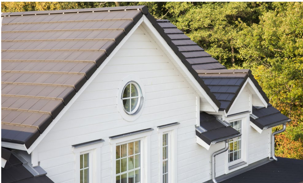
Pilt 22. Carisma katusekivid parem-vasak äärekivi.
