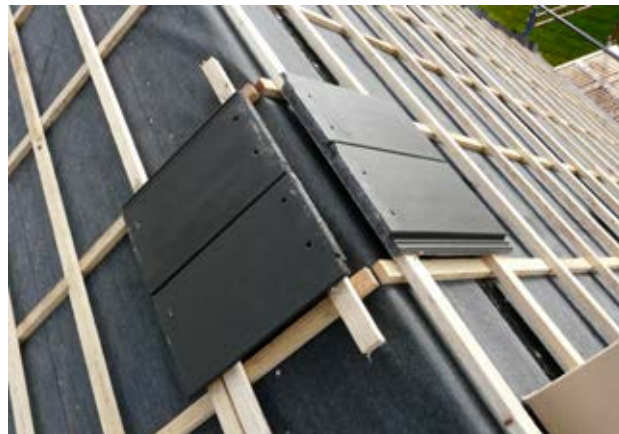
Pilt 10. Ülemiste reaktivide paigutamine.
