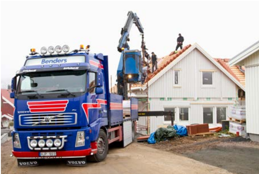
Pilt 1. Kraanaga autolt katusele tõste.
