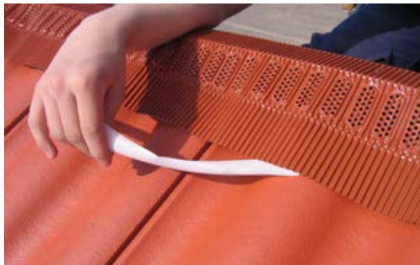
Samm 2. Eemaldage paigalduse suunas teibid tihendi alumiselt poolelt.
