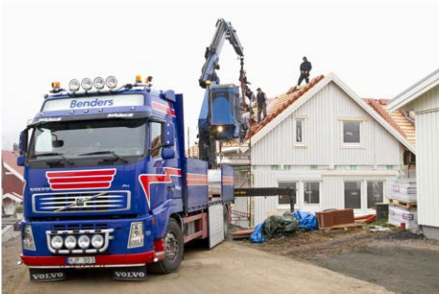
Pilt 1. Kraanaga autolt katusele tõste.
