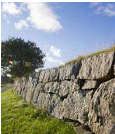
KRYSSMUR MED REJÅLA BLOCK OCH STORA FOGAR SOM GER ETT RUSTIKT INTRYCK
